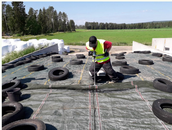
Projekti-insinööri kairaamassa reikää sensorisauvalle auman päällä.
