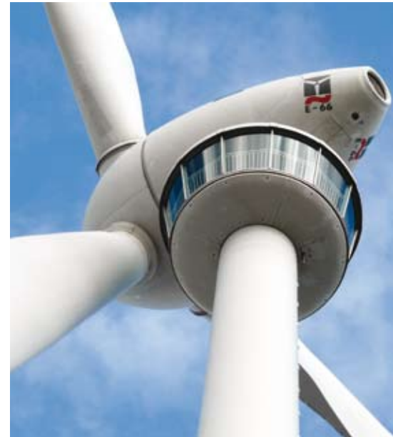
Tuulivoimala Bruck an der Leithan energiapuitossa Wienin lähellä. Voimalan maksimiteho 1,8 MW. Näköalatasanne 60 m korkeudessa.
