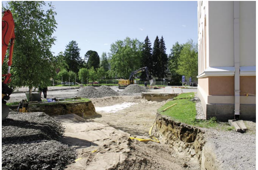
Kampuksella tehtiin laajoja kaivaustöitä kesällä 2005.
